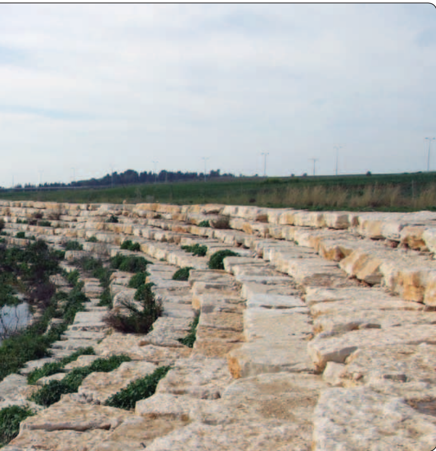
ייצוב אגרסיבי של נפתול נחל שורק בעזרת בולדרים, סמוך למושב טל שחר. תוכניות ניקוז אינן נדרשות לכלול תסקירי השפעה על הסביבה. צילום: אלון רוטשילד
